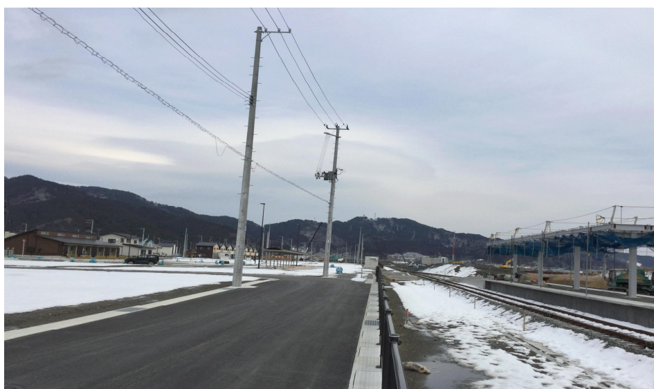
右手が大槌駅、左手奥が公営住宅
