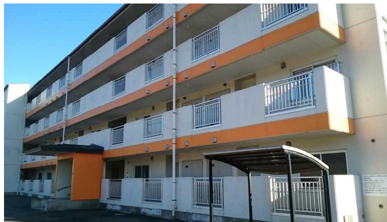
被災後改修した北浜町営住宅(1Fは倉庫などに活用)
