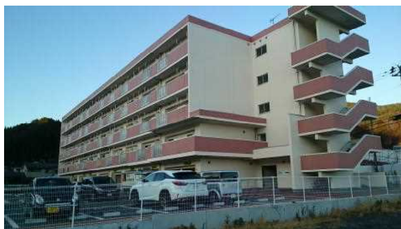
大沢地区の県営災害公営住宅
