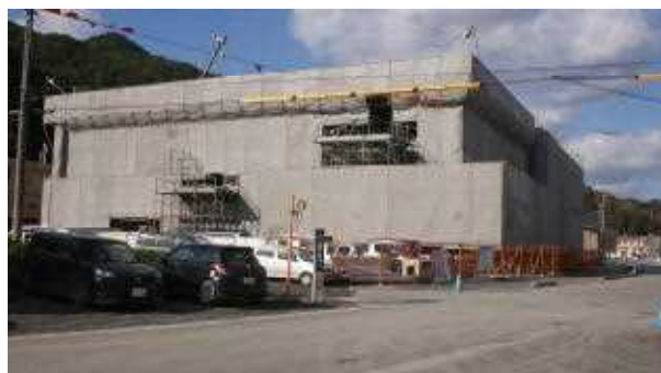
(建設中の大槌病院)
