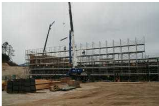
(建設中の山田病院)
